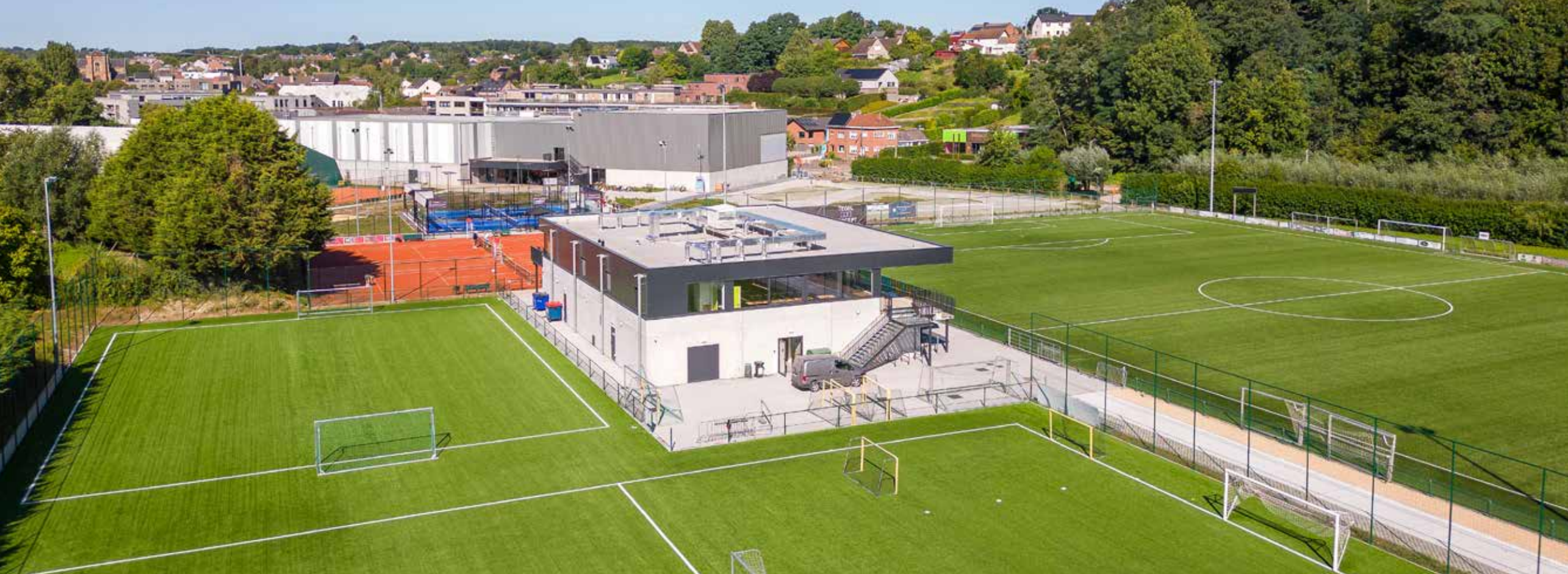
De opdracht omvatte de bouw van een nieuwe turnhal, een gezamenlijke voetbal- en tenniskantine, tennisterreinen, twee padelvelden, twee kunstgrasvoetbalvelden (achter de nieuwe kantine), een grote parking en enkele petanquebanen.
