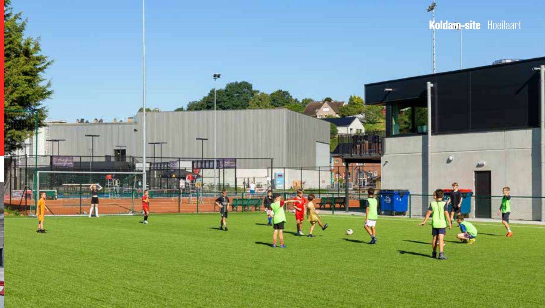
De bestaande sporthal kreeg een aanbouw met een hoogte van 10 meter (vooraan op de foto).
